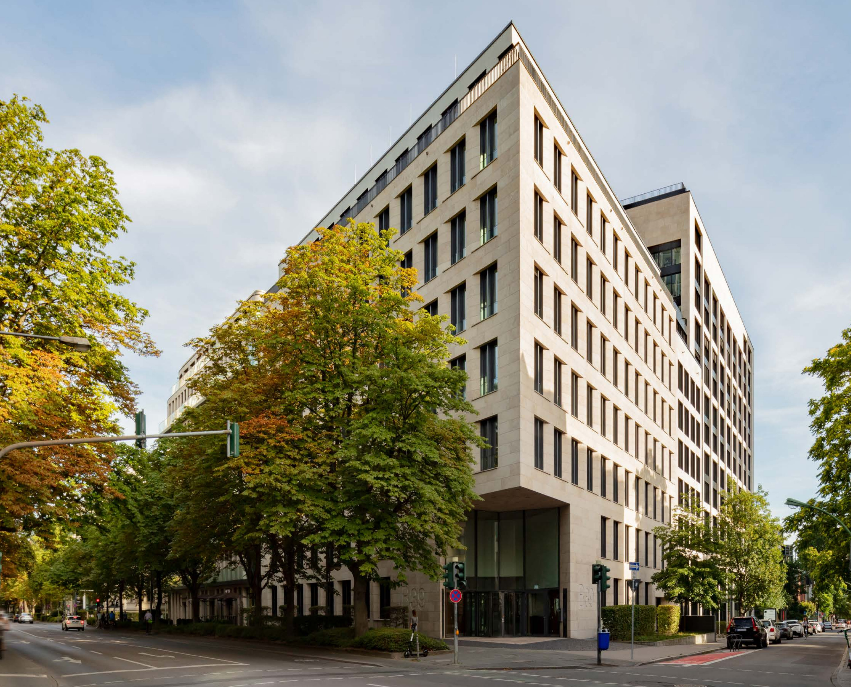
B39. Prägnant statt Stromlinie. Ecklage mit Fernwirkung.
